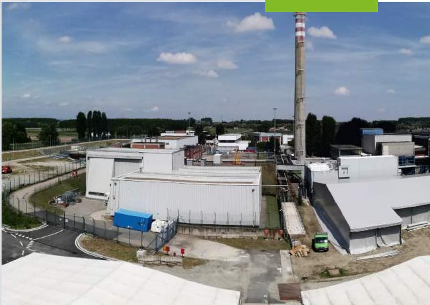
L'impianto EUREX (Enriched URanium EXtraction) entrò in esercizio nel 1970. Al suo interno venivano svolte attività di ricerca sul riprocessamento del combustibile nucleare irraggiato, per separare le materie fissili che possono essere riutilizzate. Le attività sono state interrotte nel 1984.
